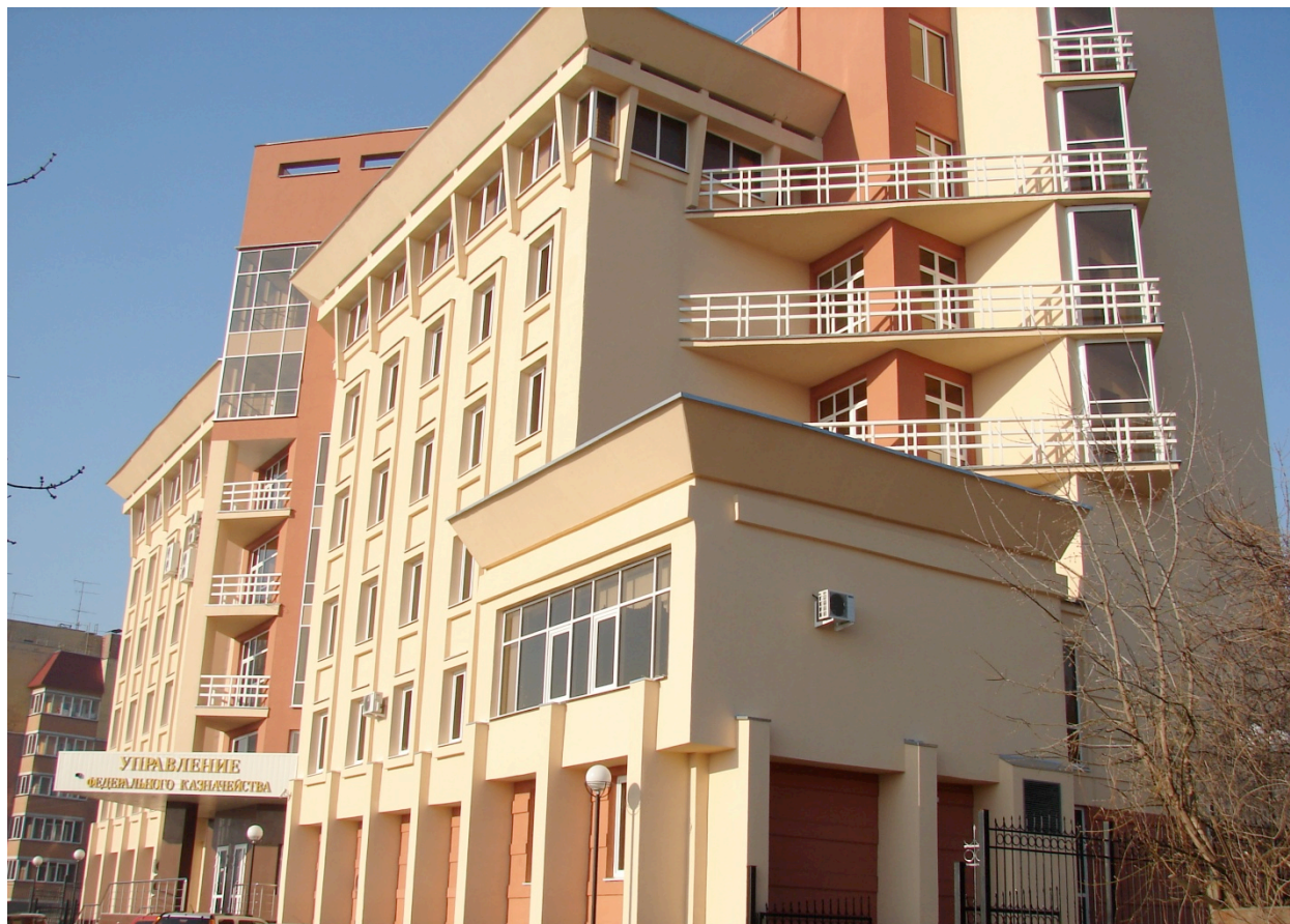
Рис. 6. Административное здание УФК по Курской области, расположенное по адресу: 305000, РФ, Курская область, Курск, ул. Володарского, д. 22 [8].
